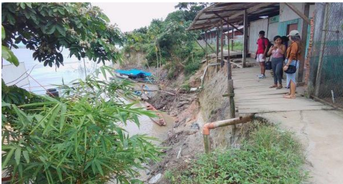
FIGURA N°03: REDES DE DESAGÜE EXPUESTOS A LA EROSIÓN FLUVIAL
